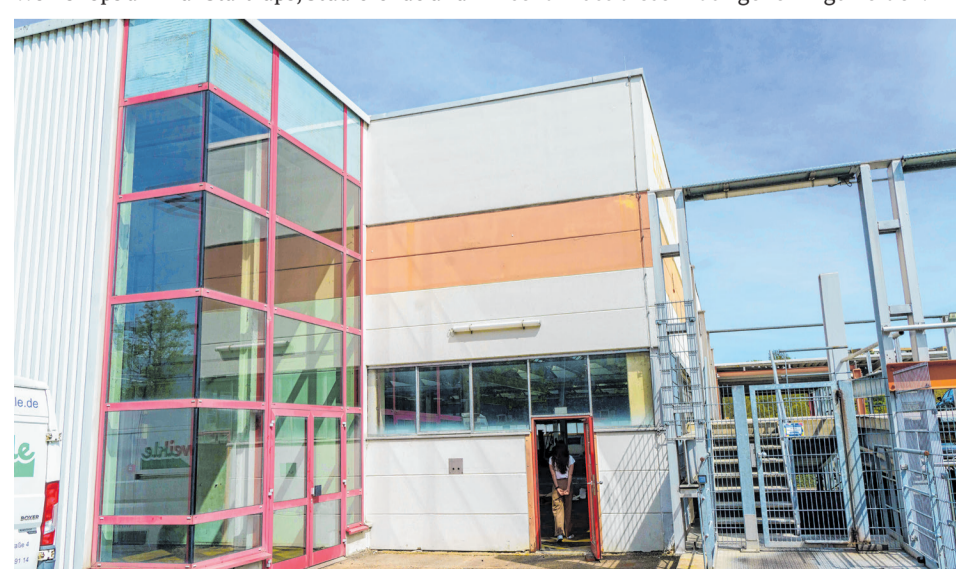
Das Start-up- und Innovationszentrum wächst: Die neue Halle wird hergerichtet. Bild: Dettenmeyer
