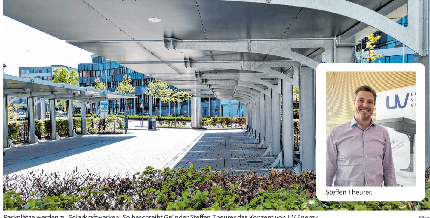
Parkplätze werden zu Solarkraftwerken: So beschreibt Gründer Steffen Theurer das Konzept von UV Energy. Bilder: z
